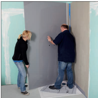
7) Duschrückwände positionieren und anbringen.
