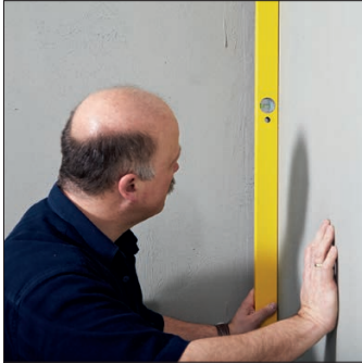
1) Bautechnische Voraussetzungen überprüfen
