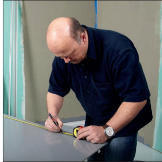
2) Aufmaß der Duschrückwand und Anzeichnen am Produkt
