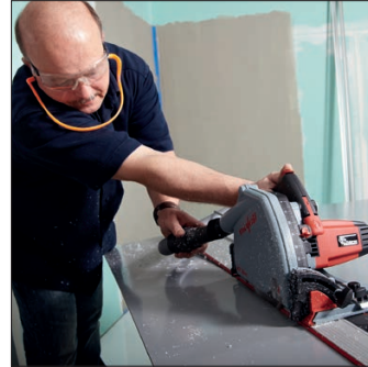
3) Zuschneiden der Wände sowie Bohrungen und Ausschnitte einbringen.
