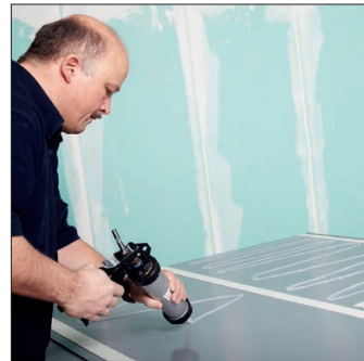
6) Silikonkleber aufbringen und Schutzfolie der Klebebänder abziehen
